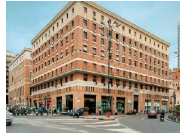
Complesso didattico di Via Medina
